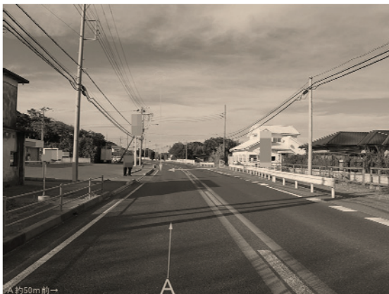
図1 道路交通環境(衝突地点手前50mから)
