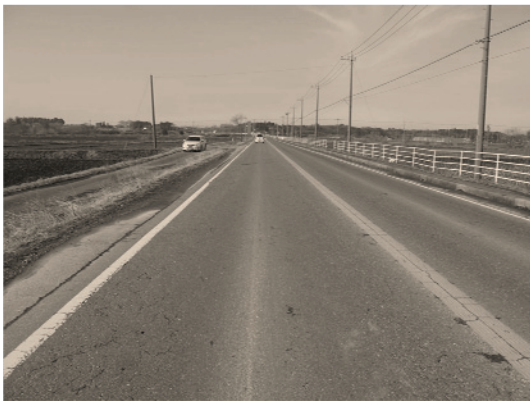
図 6 道路交通環境 (衝突地点手前 50m から)
