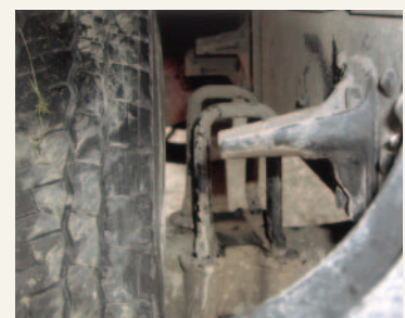
写真4 左後リーフスプリングの破損状況
