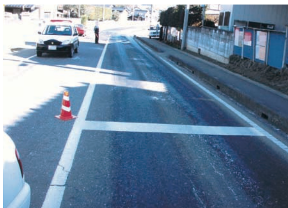
写真3 Aの進行していた道路の凍結状況
