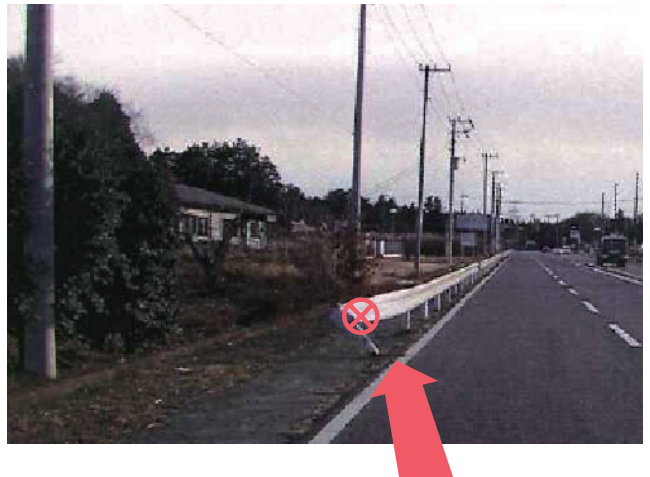
衝突相手のガードレール
